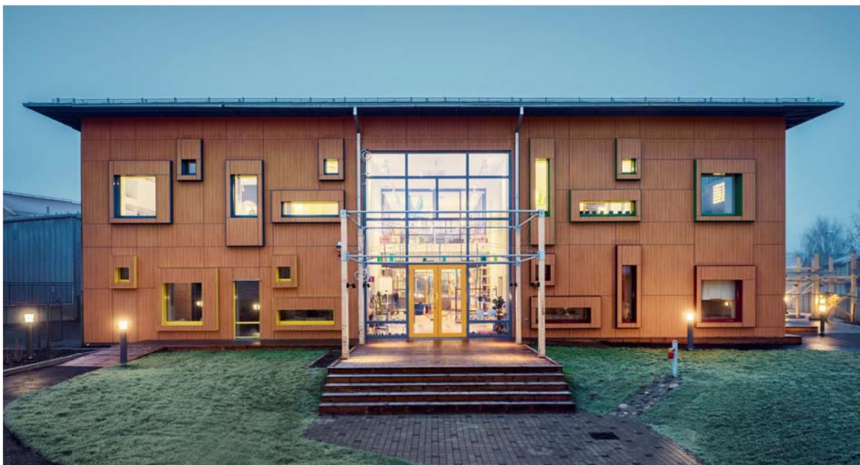
Bild från Hedlunda förskola i Umeå som visar en tydlig och välkomnande huvudentré.
