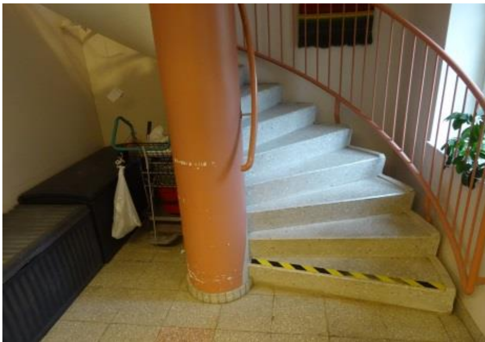
Exempel på kontrastmarkering av trappa. Även ledstång och pelare har kontrastmarkerats.
