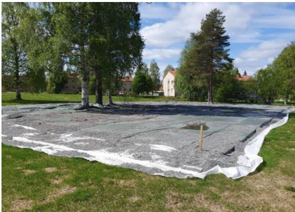
Figur 3 Tjältskydd utlagt på fastigheten i ungefärligt läge för planerad förskola.
