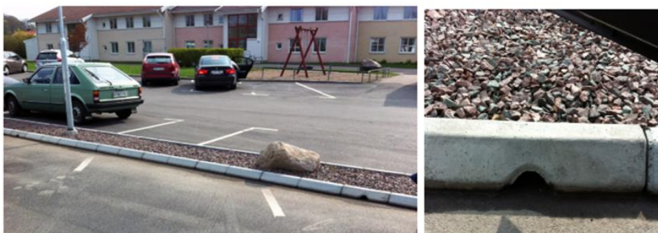
Figur 12. Exempel på makadamdike. Bilden till höger visar inloppet till makadamdike (Stockholm Vatten och Avfall).
